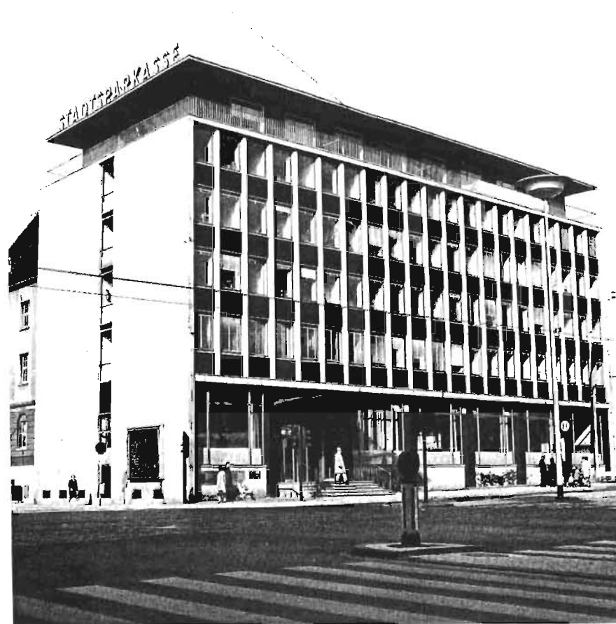
Gebäude der Stadtsparkasse Essen-Rüttenscheid auf dem Gelände des ehemaligen Rathauses
